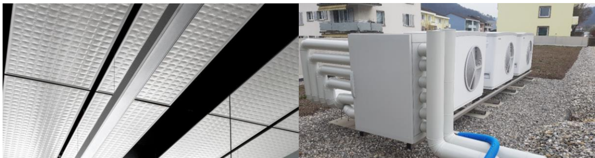
Grafik: Bild links – Kigo Panels (Quelle: Energie Solaire SA), Bild rechts – 3er-Kaskade Wärmepumpen (Quelle: Stiebel Eltron AG)
